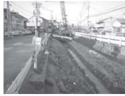
阪急茨木市駅島線工事風景
