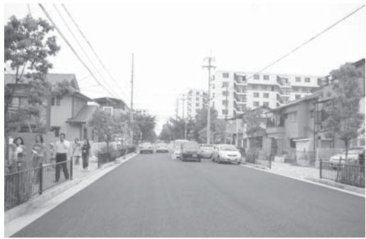
阪急茨木駅島線新設区間
