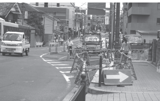
茨木高校前工事中写真
