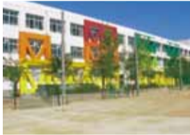
耐震工事が完成した 中学校校舎(南中学校)
