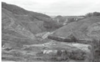
安威川ダム本体工事風景
