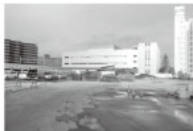
(仮称)JR総持寺駅前工事風景
