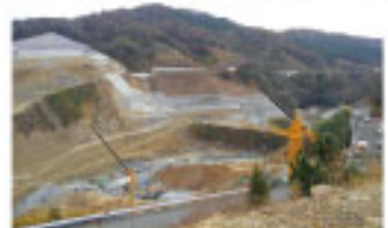
工事が進むダム工事現場
